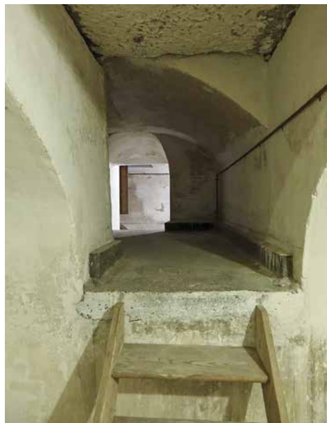
Doorkijkje vanuit de nieuwe kelder
